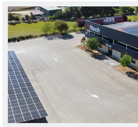
Ilustración 9. Placas fotovoltaicas de la fábrica de Alltech Spain en Almoguera, Guadalajara.
